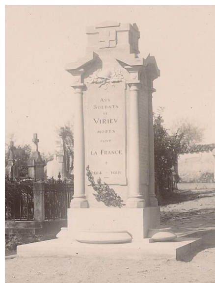
L'ancien monument aux morts de Virieu, auteur inconnu (archives AHTF).
