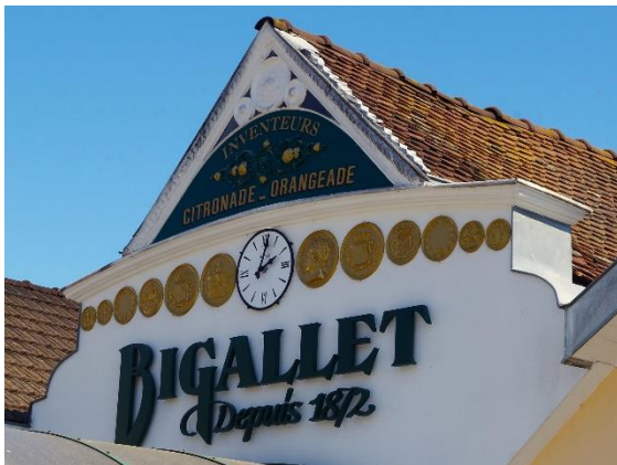
Détail de l'entrée principale du site Bigallet.
