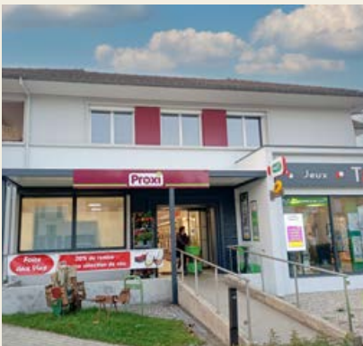
Ancien bâtiment de la Poste
