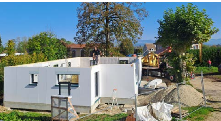
Photo d'une micro-crèche identique en construction à Pressins
